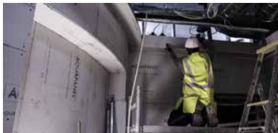
TIDSBESPARANDE MONTAGE AV YTTERVÄGGAR SID. 6
