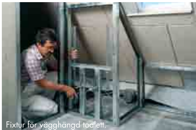
Spolcistern och installationsrör för vägghängd toalett.
