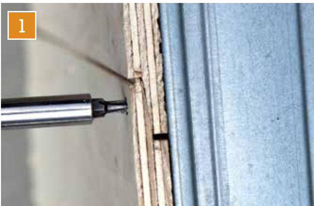
Första skivan fästes först i ytterkant och sedan mitt i skivfältet. Montering sker med falsen utåt & uppåt (se bild) eller inåt & nedåt. Observera att ett fanérskikt släppts upp för att skapa en expansionsfog. Skivorna skall monteras så att detta fanérskikt alltid är vänt åt samma håll, antingen upp eller ned. Skivorna får ej vändas så att fanérskikten från två skivor möts i en fog.
