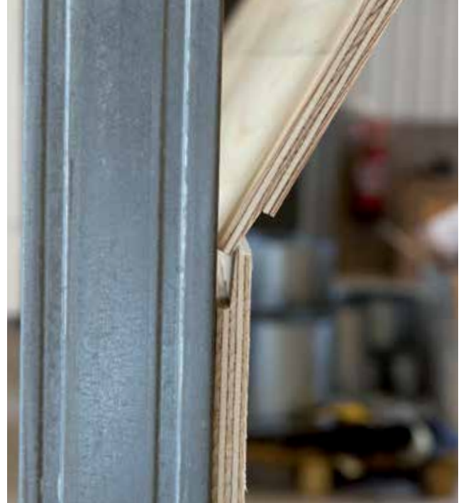
RAW Ergo Wall har två falsade sidor för snabb och säker montering.
