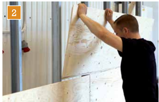
När första skivraden är monterad ställer du enkelt i nästa skiva. Skarvning på regel är inte ett krav. Om en styvare konstruktion önskas, skarva då skivorna på regel. Längden 2398 mm är anpassad för centrering på regel inkl. expansionsfog vid montering c/c 600mm.
