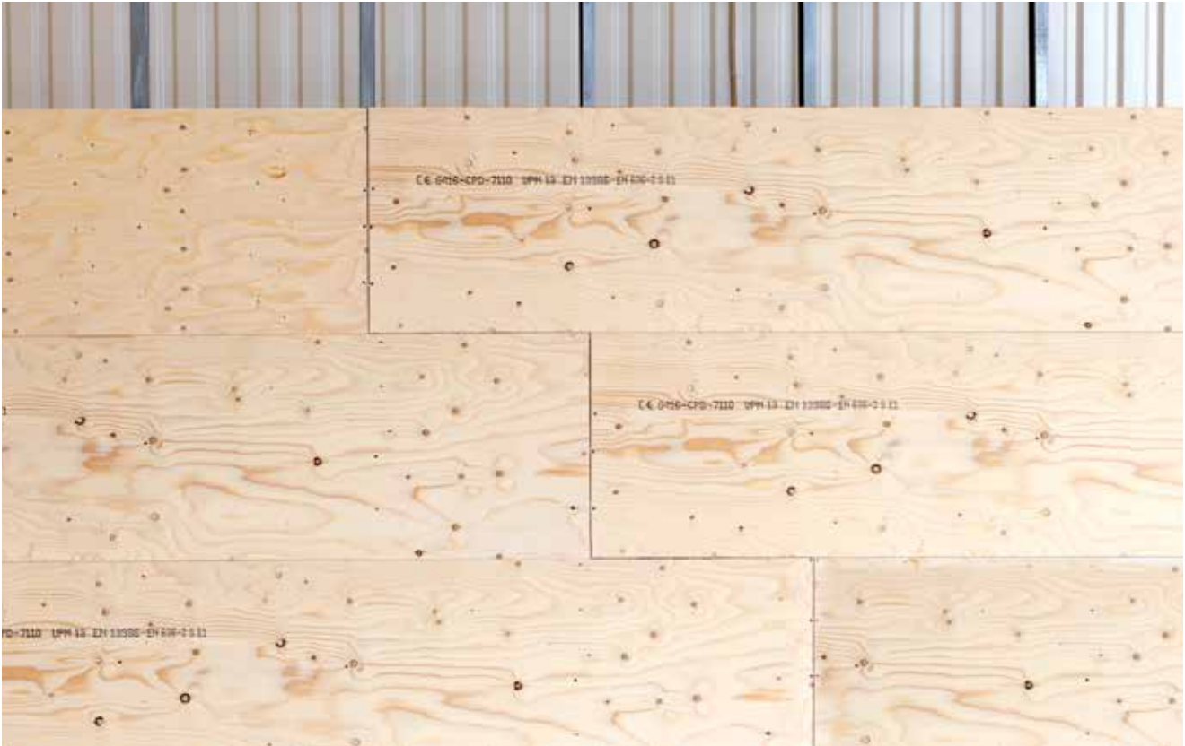
Vid skarvning mellan reglar på c/c 600 mm får två intilliggande rader EJ skarvas i samma regelfack, s.k. generalskarv.
