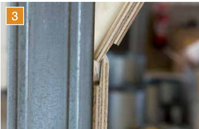
För att underlätta monteringen så har skivan försetts med en lätt vinklad fals. Detta ger en mindre invikningsvinkel.
