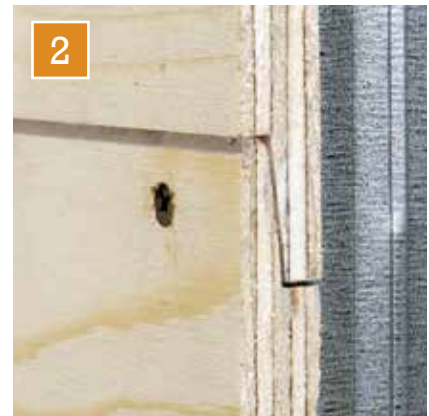
Vid skruvning på skivfält fixeras skivorna med skruv genom båda skivornas falsar på c/c 300 mm.
