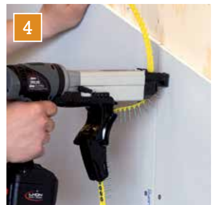
När väggen är täckt med plywood kan den täckas med t.ex. gips.
