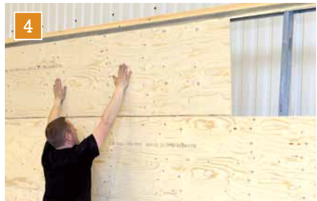
Montering sker sedan löpande till väggen är klar. När en rad är klar kan du ta resterande bit att starta på kommande rad, förutsatt att längden på skivan överlappar minst ett regelfack (>600mm).
