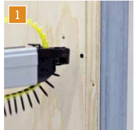
Där väggen börjar eller slutar fixeras skivan med skruv intill falsen på c/c 300mm. Obs! Ej i falsen.
