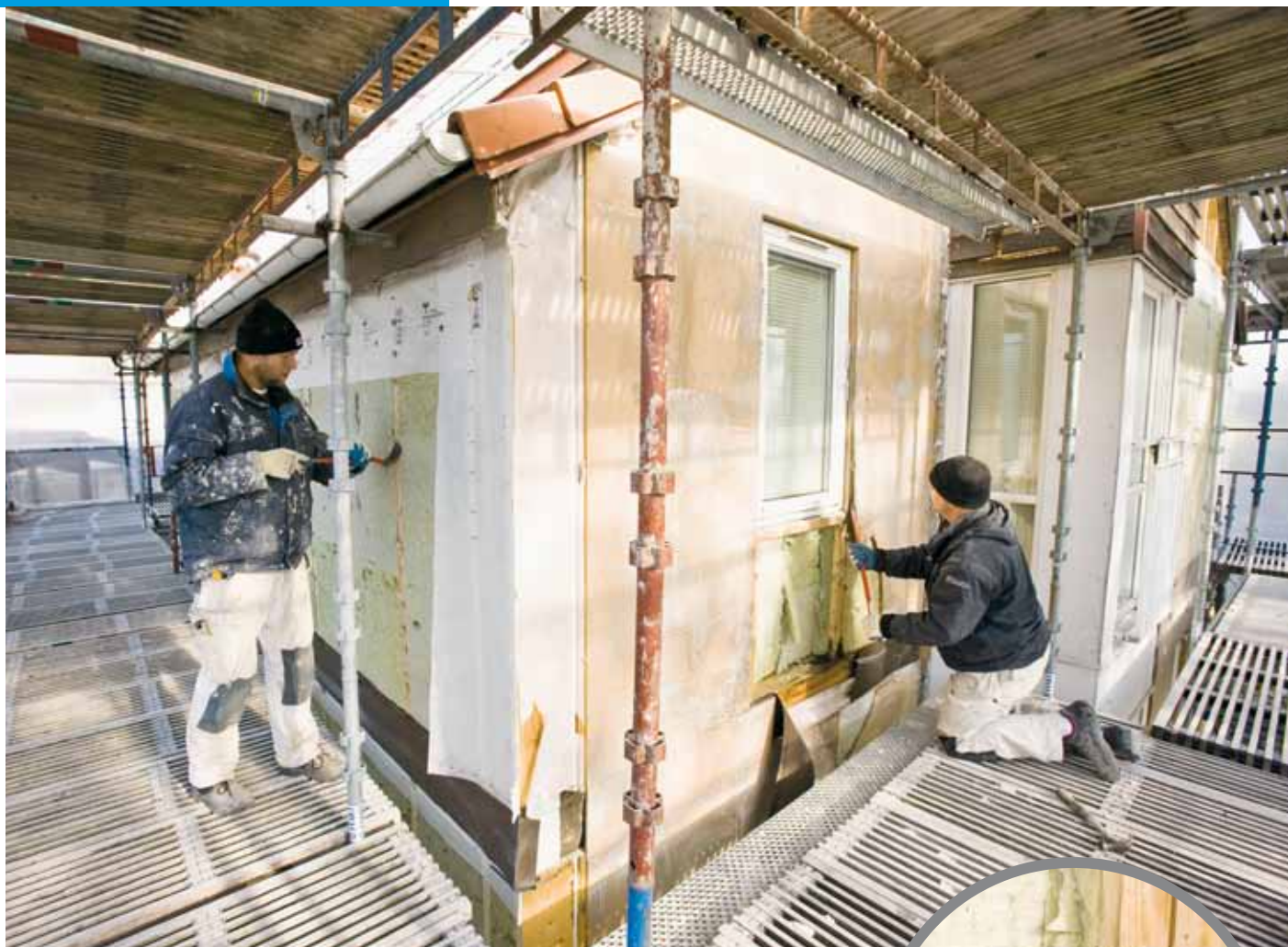
Malmö Mur och Puts AB renoverar fuktskadade fasader i ett villaområde utanför Malmö. De gamla fasaderna rivs ned och huset får torka ut. Därefter monteras ventilerat och tvåstegstätat Knauf ventilerat Fasadsystem Aquapanel med puts.
