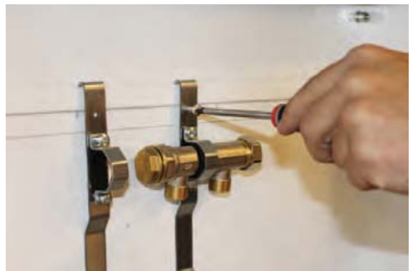
5. Kun jakotukit on asennettu, konsoli lukitaan kiristämällä ruuveja ylimpään kiskoon.
