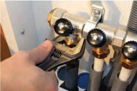
11. Røren kobles til fordelerrørene.
