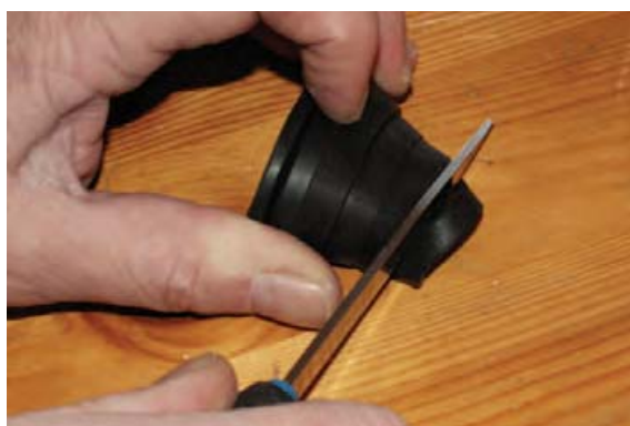
7. For RiR med 25 mm varerør benyttes LK:s ferdigkappede LK Skapgjennoføring 25, NRF 511 72 99. Artikkelen bestilles separat.
