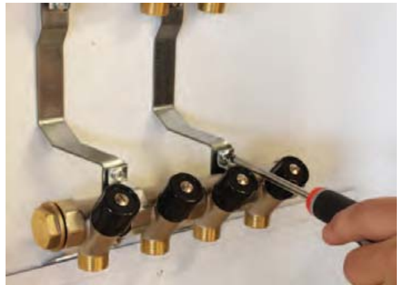
4. Asennettaessa jakotukkia konsoliin, kumipäällysteisen kannakkeen ruuveja löysätään. Kun jakotukki on paikallaan, kaikki ruuvit kiristetään.
