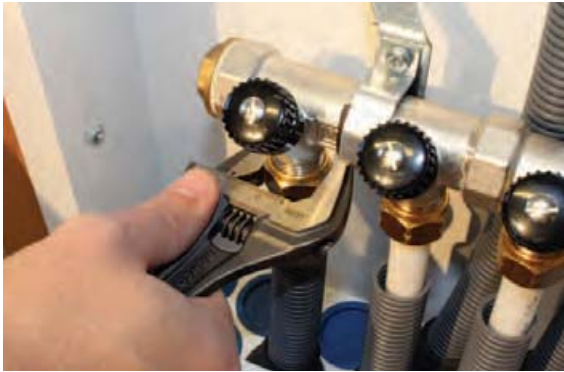
11. Putket kytketään jakoputkiin.
