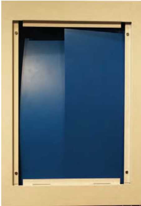
16. Kiinnitä roiske- ja likasuojat. Nämä tulee olla kiinnitettynä kaappiin rakennuksen aikana suojana lialta ja pölyltä
