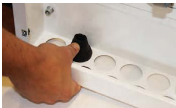
8. Skapgjennoføringen trykkes på plass i hullet slik at den tetter skikkelig. Pass på at ingen bygningsdel f.eks. stendern eller plate trykker mot skapgjennoføringer da dette kan forårsake lekkasje.
