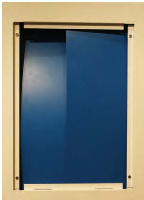
16. Sprut- og smussbeskyttelse monteres. Tips, disse bør være montert under byggetiden, dette for at forhindre smuss og støv i skapet.
