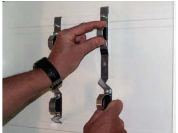
3. Konsolit on toimitettaessa ruuvattu yhteen. Ne sovitetaan ja kiinnitetään kaapin kiskoihin sopivalle etäisyydelle toisistaan jakotukin koosta riippuen.
