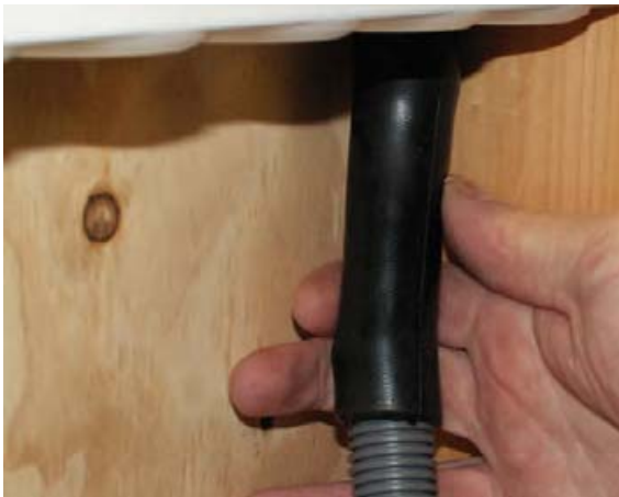
12. Mukana seuraava kumimuhvi pujotetaan vuodonilmaisinaukkoon. Vuodonilmaisussa käytettävä suojaputki painetaan kumimuhviin. Suojaputken suositeltu enimmäispituus on 1,5 metriä ja se asennetaan kallistuksella (katso kohta 2).
