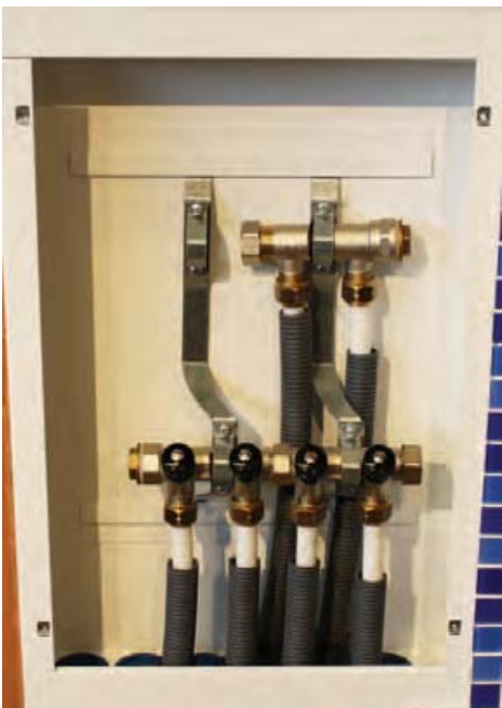
17. Kehys kiinnitetään kaapin päälle mukana seuraavilla ruuveilla.
