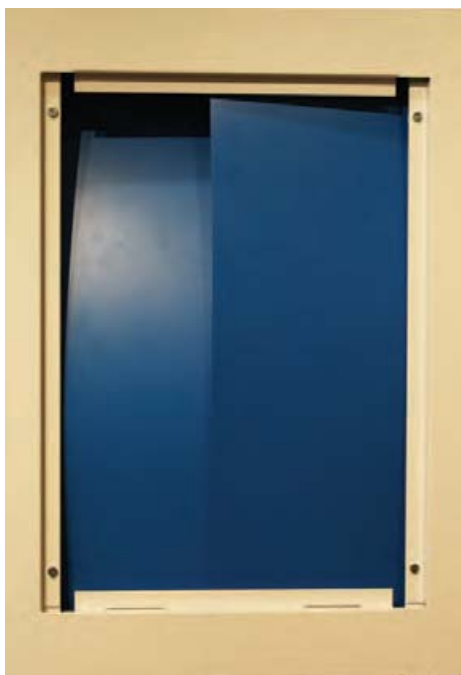
16. Montera sprut- och smutsskydden. Bör vara monterade under byggtiden för att förhindra att smuts och damm kommer in i skåpet.
