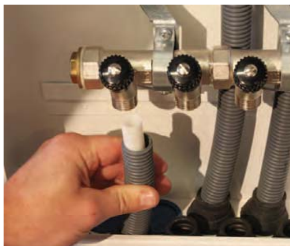
9. Røret med varerør dras deretter opp i skapgjennoføringen og kappes/grades.
