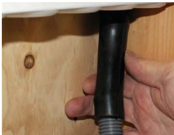
12. Medföljande gummimuff träs på uttaget för läckageindikering. Tomröret som ska användas för läckageindikering trycks in i gummimuffen. Max rekommenderad tomrörslängd 1,5 m och förläggs med fall (se punkt 2).
