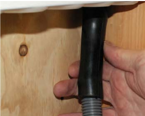
12. Medleverte gummimuffe monteres på utaket for lekkasjeindikasjonen. Varerøret som skal benyttes som lekkasjeindikasjon presses in i gummimuffen. Maksimal varerørslengde er 1,5 m og skal monteres med fall (se punkte 2).
