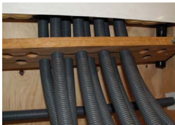
Tips: RiR-fikstur 25-8 (NRF 511 72 82) kan med fordel benyttes for at sentrere røren til fordelerstokken.
