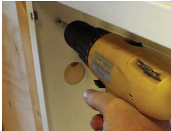
2. Kaappi asennetaan tarvittavalle korkeudelle lattiasta niin, että saadaan riittävä kallistus kohti vuodonilmaisimen aukkoa seinästä. Jakotukkikaappi kiinnitetään sivuilta neljällä mukana seuraavalla ruuvilla.
