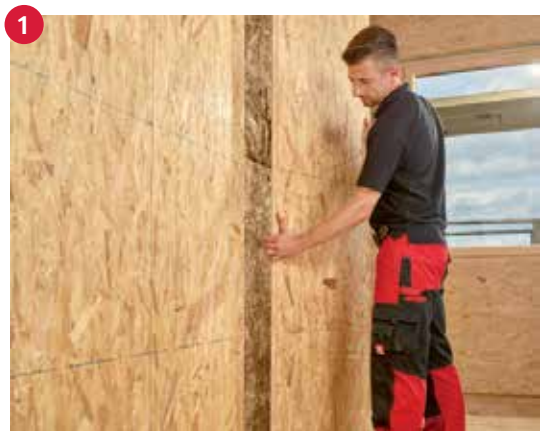
1 Ställ Ergo Boarden i vertikal position.
