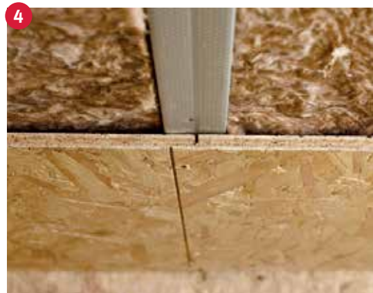
4 Fixera angränsade paneler med en skruv i stålregeln.
