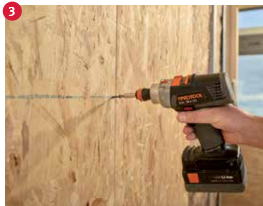
3 Fäst Ergo Boarden med 150 mm mellanrum.
