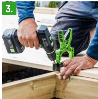
3. Vinkla skruvdragaren så att batteriet inte slår mot trallbrädan, då minskar risken för felmontage samt skador på monteringsverktyg och bits.
